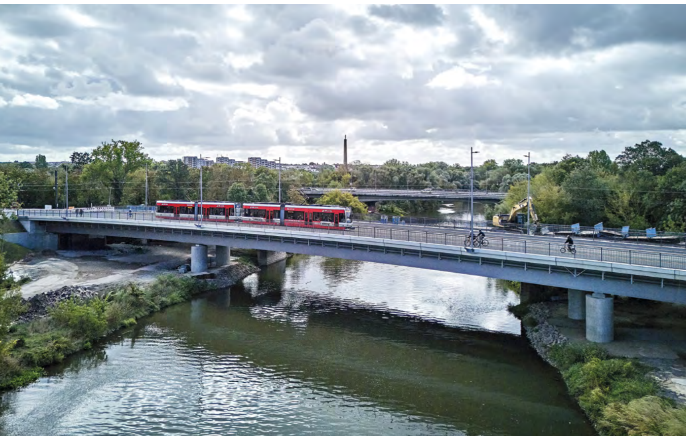
BLICK VON NORDEN AUF DIE IN BETRIEB GENOMMENE STRASSENBAHNBRÜCKE IN VTR®-BAUWEISE Abbruch Bestandsüberbau und Ufergestaltung mit Saaleradweg noch nicht abgeschlossen.
