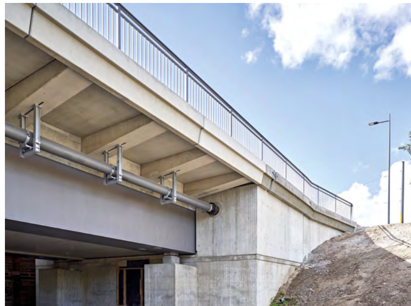
SEITE NORDWEST, ÜBERGANGSBEREICH ÜBERBAU ZUM WDL IN ACHSE 40
