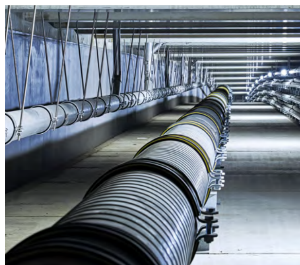
BLICK IN DEN BEGEBAREN ÜBERBAU-MEDIENKANAL
