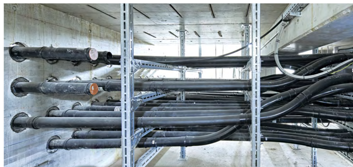
BLICK IN DIE WIDERLAGERKAMMER ACHSE 10; ÜBERGABEPUNKT „HAUSANSCHLUSS“ IN DAS STÄDTISCHE UMFELD
