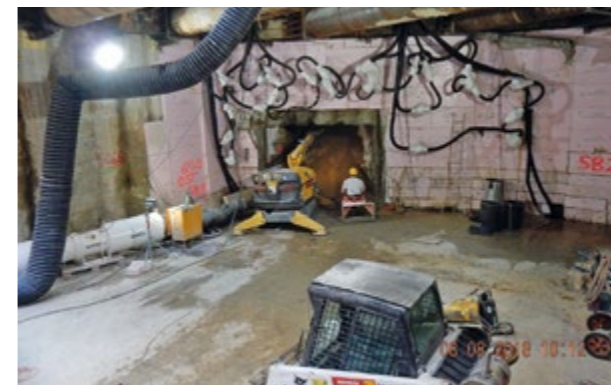
HERSTELLUNG DURCHBRUCH ZUR BAHNSTEIGRÖHRE IM VERLEISUNGSBEREICH DES QUERSCHLAGS SONNENSTRASSE
