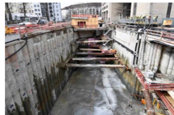
BAUGRUBE QUERSCHLAG BLUMENSTRASSE
