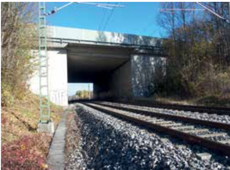
4 Bauwerk BW 27/1: Unterführung der S-Bahn-Linie S 8 © Autobahndirektion Südbayern
