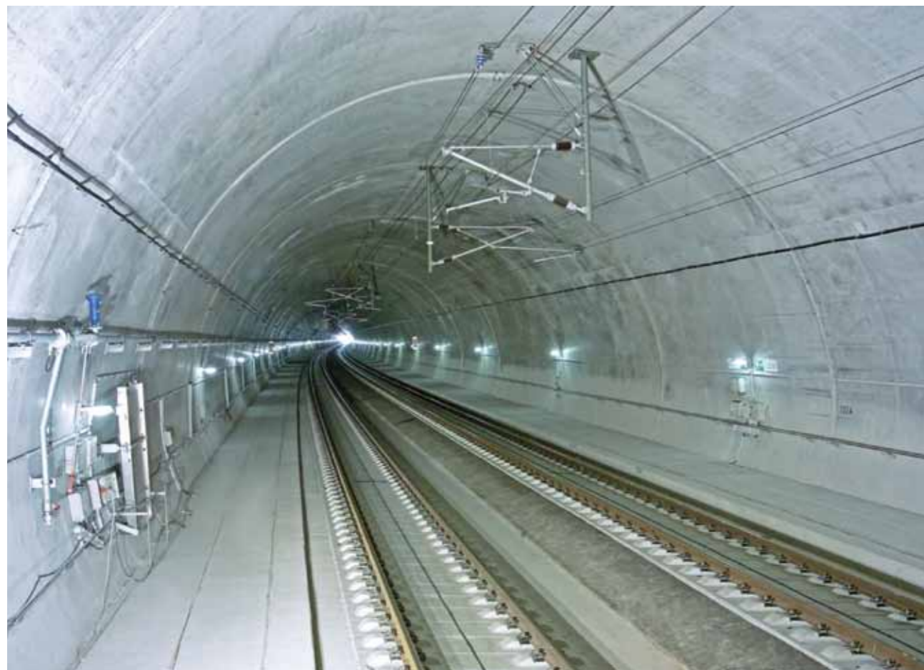
Tunnel Göggelsbuch – Haupttröhre Richtung Nord
