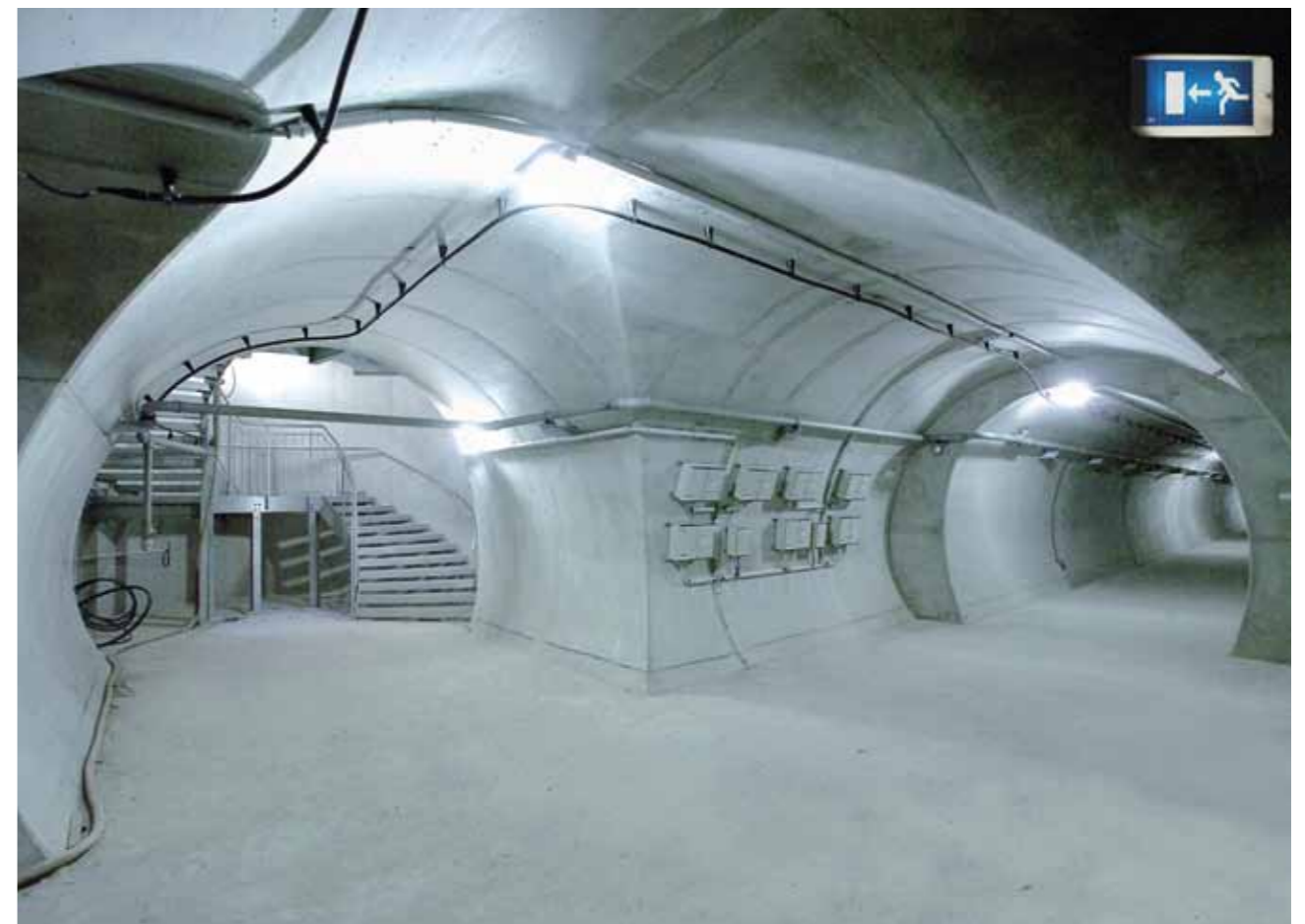
Tunnel Göggelsbuch – Notausstieg Richtung Rettungsschacht
