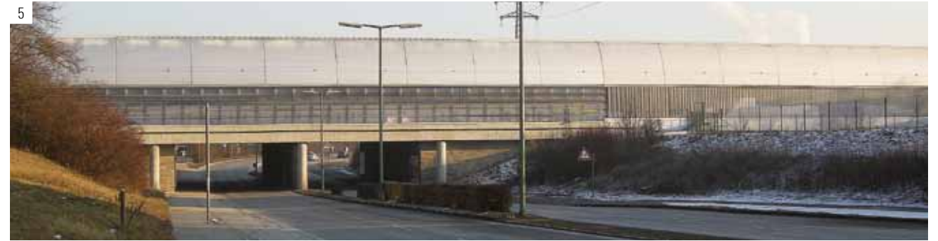
1+2 Lärmschutzbrücke mit punktgelagerter Planarverglasung – A 9 Unterführung Schleißheimer Kanal bei Garching 3 Transparentes Querschott an einem breiten Unterführungsbauwerk – A 9 Garching – Unterführung der B 471
