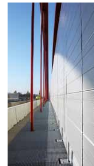
Aluminiumkassetten mit Verblendung der Pfosten – A 8 West / Mittelwand auf der Lechbrücke Augsburg
