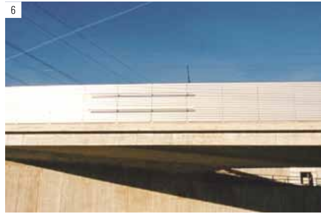
4 Punktgelagerte Acrylglaswand – A 96 / Halbanschluss Freiam 5 Punktgelagerte Acrylglasplatten – A 8 West / Lechbrücke Augsburg 6 Aluminium-Großflächenelemente – A 99 / Überführung Güterumgebungsbahn bei Allach
