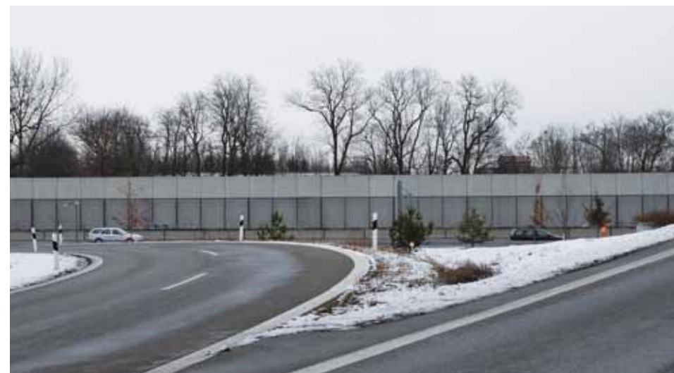
Betonwand mit vorgesetzten Pfosten-Drahtgitterverblendung – A 9 / München-Fröttmaning
