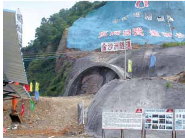
6 Nordportal Jinsha Zhou Tunnel, Baubeginn 2006
