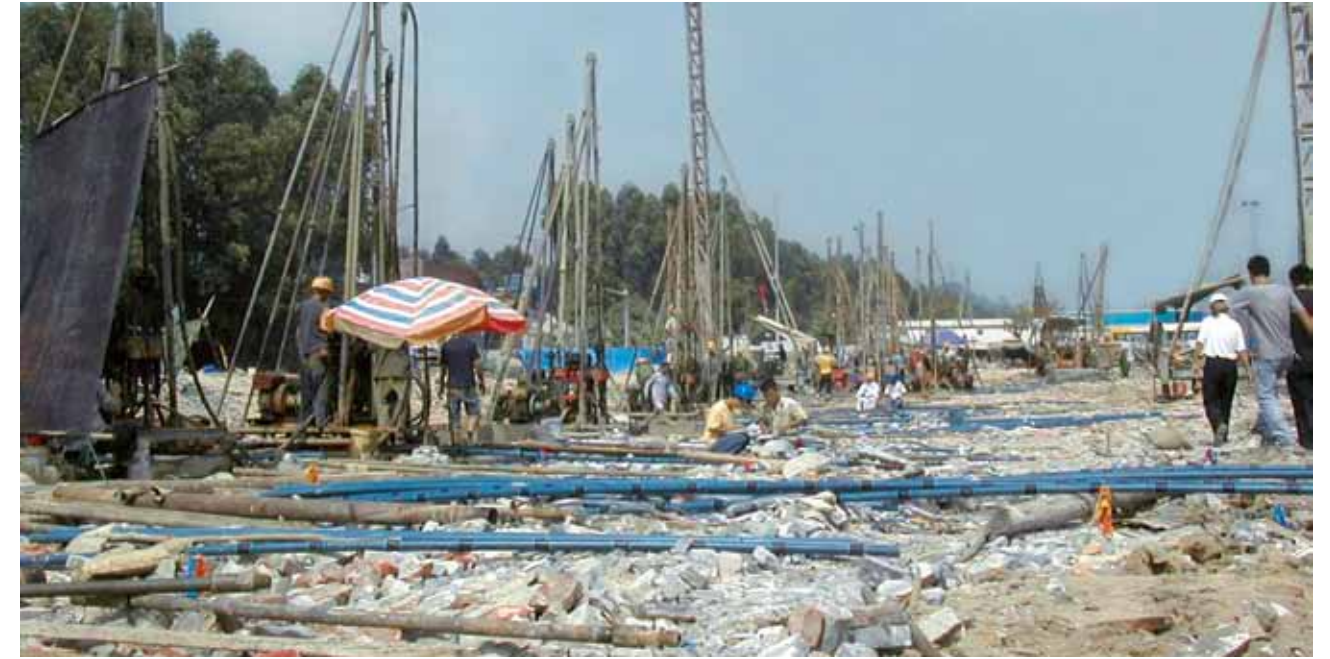
9 Hochdruckinjektionen am Vertikalschacht 1
