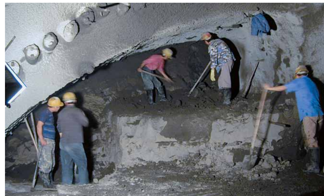
12 Vortrieb mit Handarbeit in Temporärschacht 3
