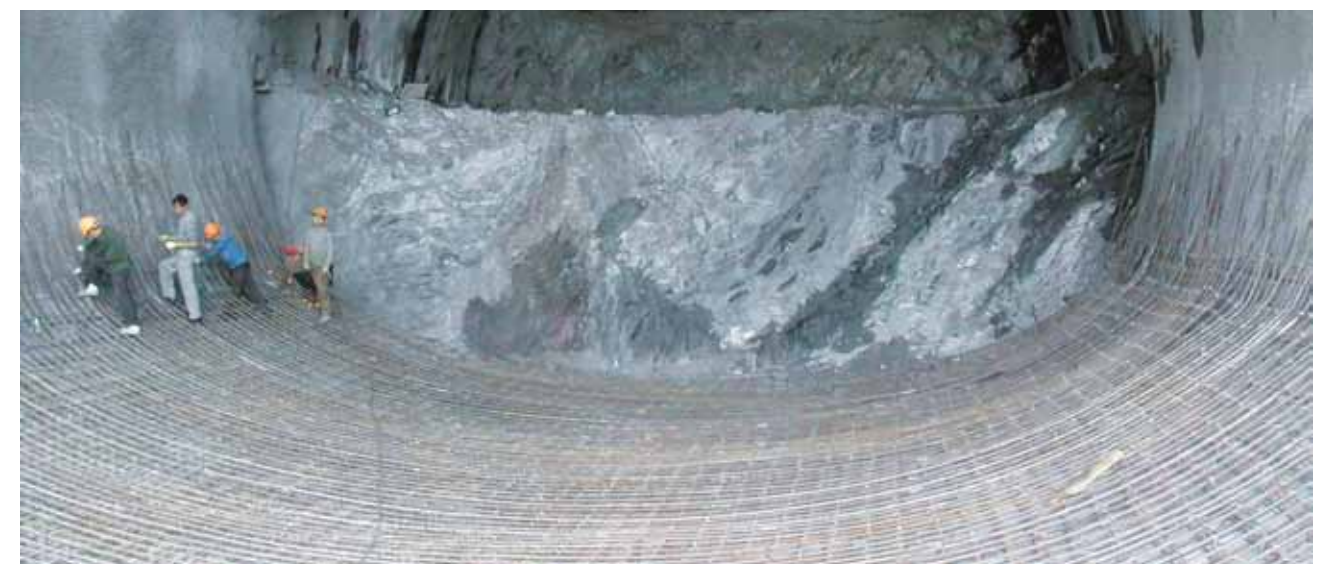
14 Strossen – Kalotten – Vortrieb in Devonquarziten mit Sohlbewehrung am Nordportal
