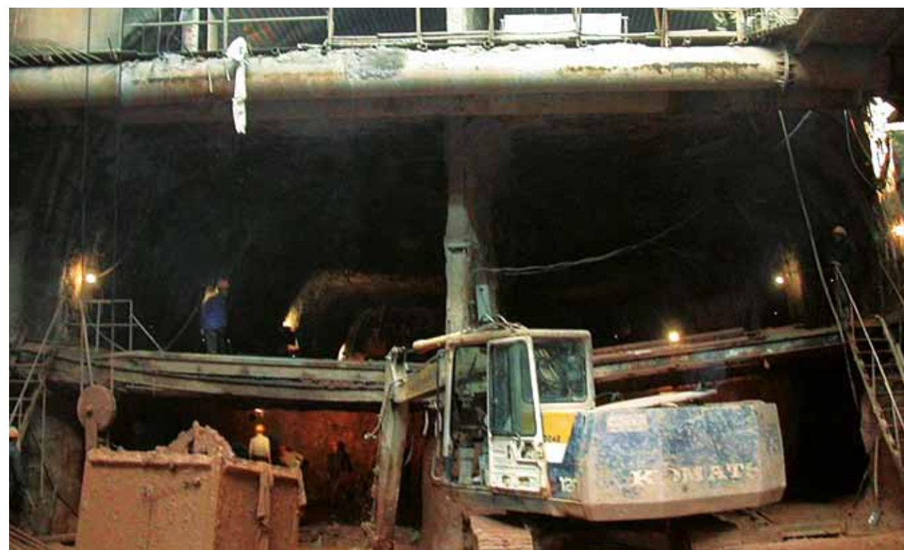
11 CRD Vortrieb vom Temporärschacht nach Norden
