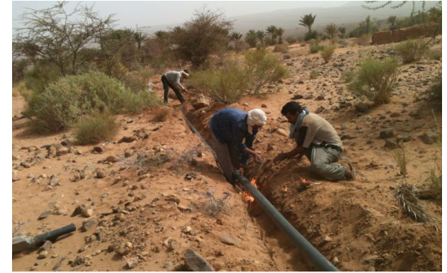
Mitglieder des Vereins „Association Akbar for Development and Culture Sustainable“ beim Verlegen einer Wasserleitung
